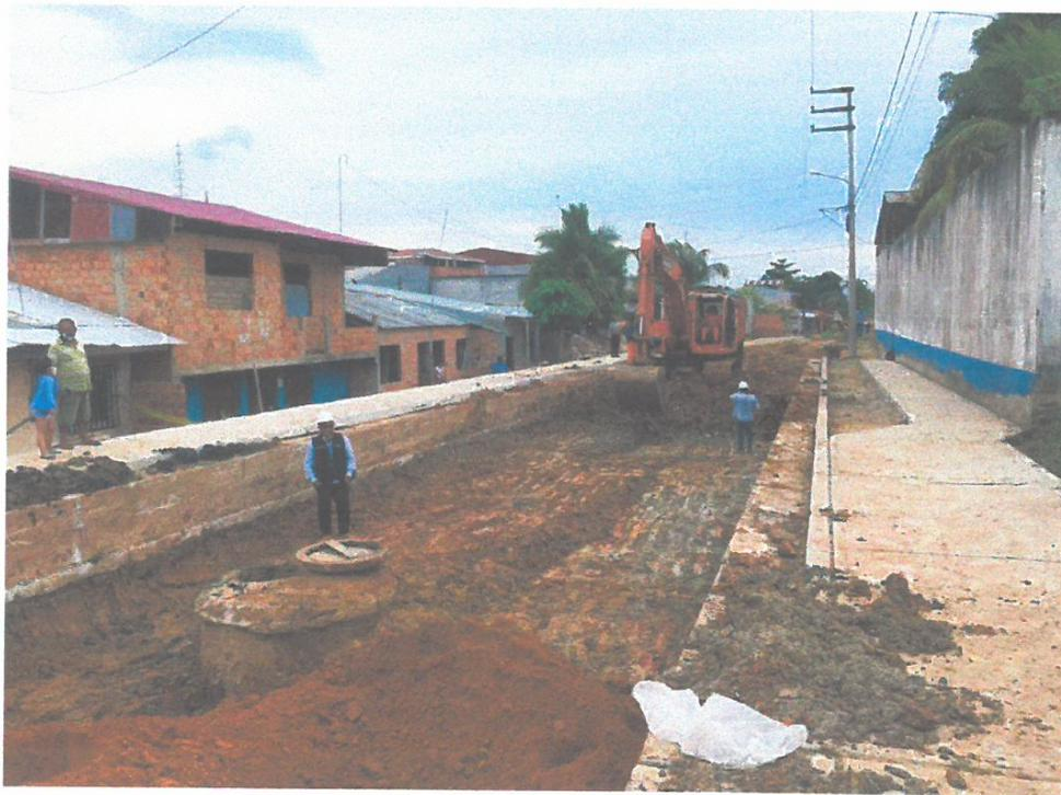
Fotografía N°02. Trabajos de corte de terreno a nivel de sub rasante, en la calle Tarata.
