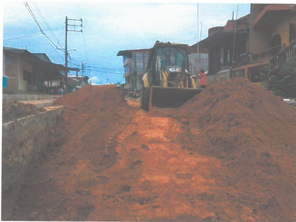
Fotografía N°03. Trabajos de relleno compactado con material de préstamo a nivel de sub rasante, en la calle Tarata
