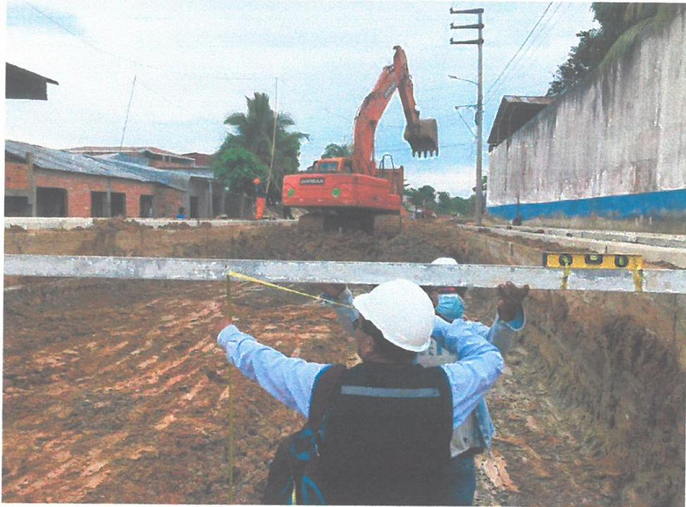
Fotografía N°01. Verificación de las alturas en corte a nivel de sub rasabte, en la calle Tarata.
