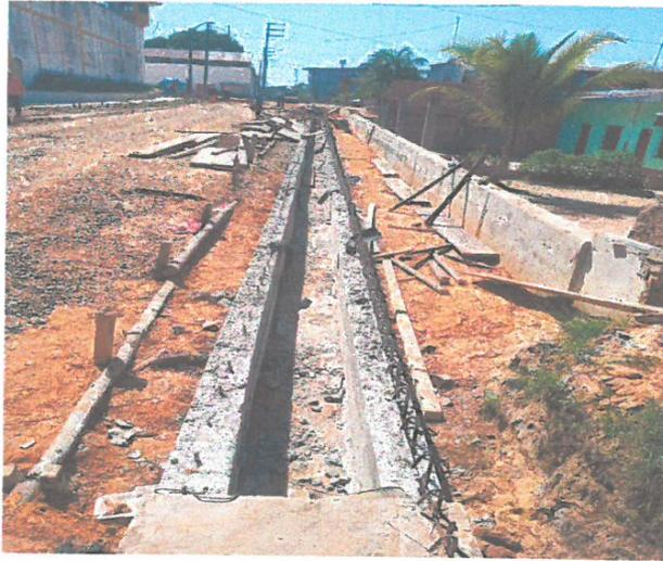
ENCOFRADO Y DEENCOFRADO DE LATERALES DE CUNETETA EN LA CALLE TARATA CUADRA 07, LADO DERECHO.
