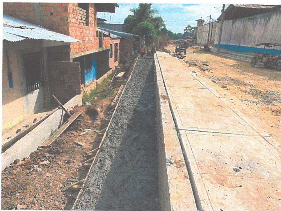
Fotografía N°04. Se aprecia la colocación de concreto en rampa cuadra 6 de la calle Tarata
